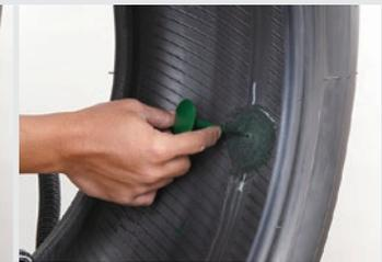
**12** プラグパッチ先端の金具をタイヤ内側から外側に向け差し込みます。
